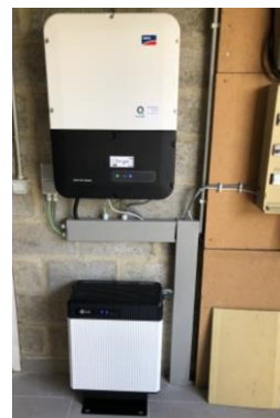
Omvormer (boven) en de LG RSU10 thuisbatterij (onder) (Q-Home).
